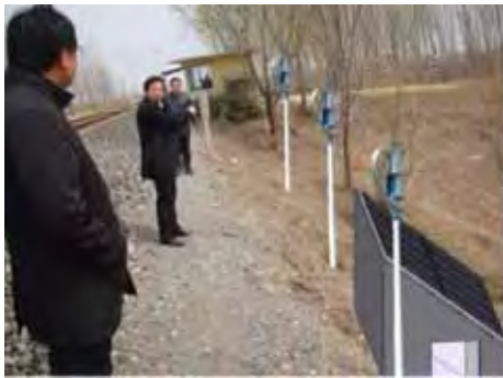
铁路道口信号灯及值班人员用小电站
