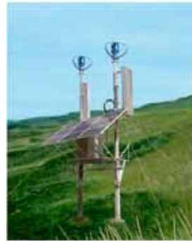
通信基站用风光互补小电站
